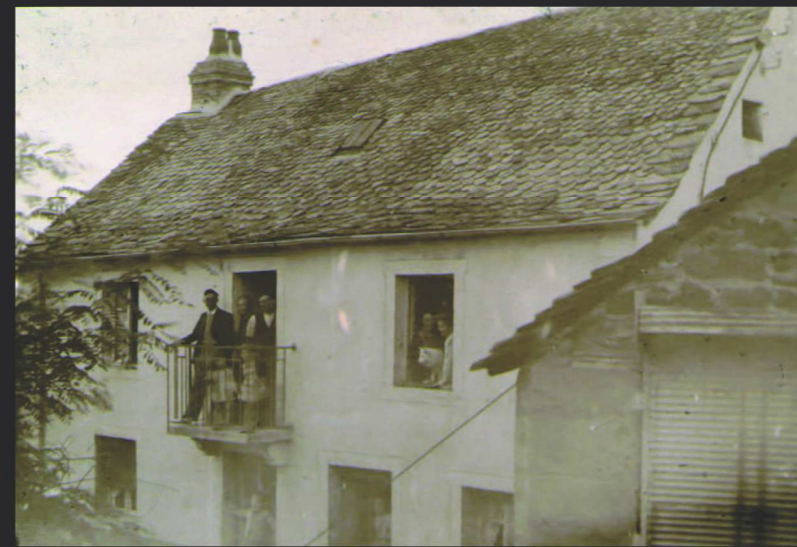
DÉBUT 20 e SIÈCLE – Maison appartenant aux instituteurs Chintard. La classe y a été transférée avant 1914 suite à un tremblement de terre qui avait fragilisé le mur arrière de l'école.
